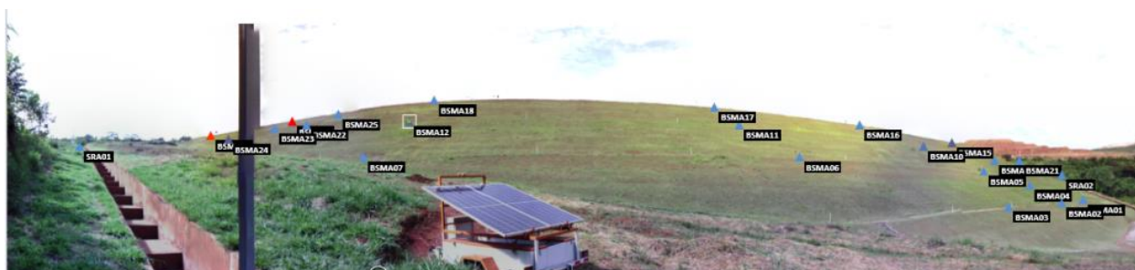
Figura 5 – Tela do GMS com a imagem da barragem com o posicionamento dos prismas
