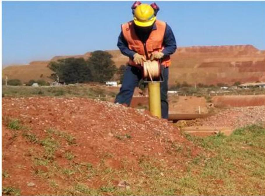
*O monitoramento ocorre em conjunto com as inspeções de campo, e inclui leituras de instrumentos manuais e campo e leituras automatizadas e monitoramento por meio da sala de controle.*
