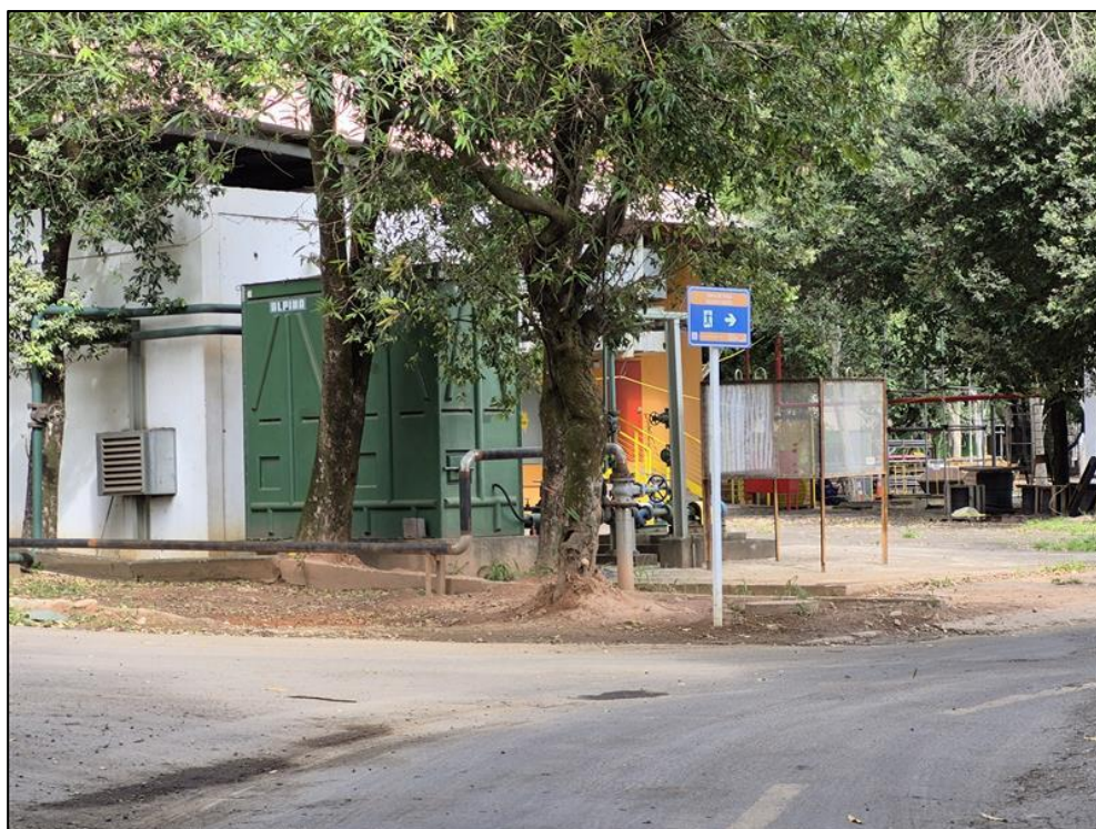
Figura 9-1– Exemplo placa de rota de fuga instalada na área da indústria.
