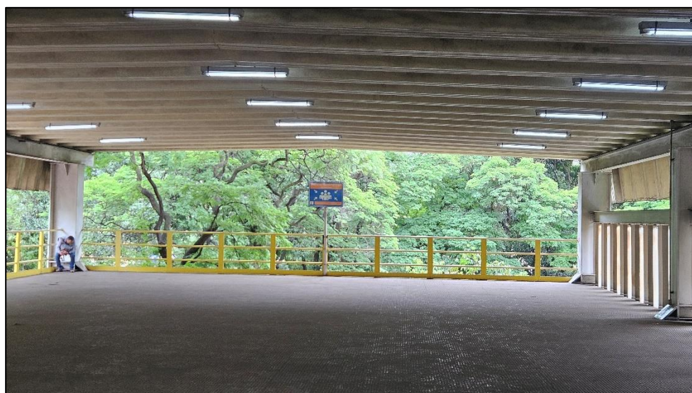
Figura 9-2– Exemplo de placa de ponto de encontro instalada na indústria.
