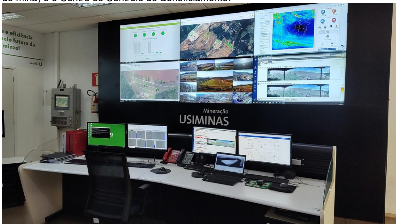
Figura 3-2 – Centro de Monitoramento Geotécnico.
